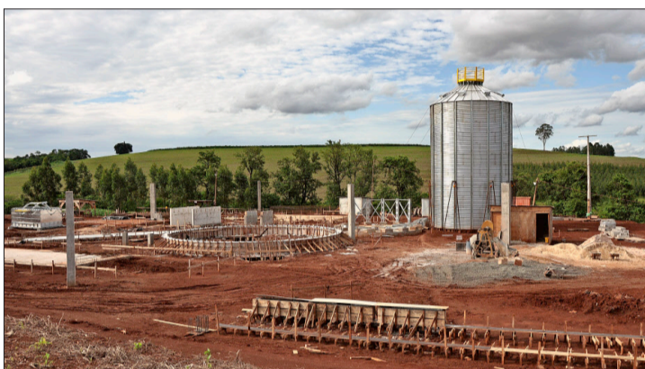
Um die Ernte länger lagern und dadurch bessere Preise lösen zu können, baut Noel Schweizer Getreidesilos.
